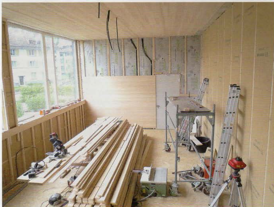
Auch die inneren Werte der Konstruktion sind hölzern, denn die Außenwände wurden mit einer Innendämmung aus Holzfasern versehen.
