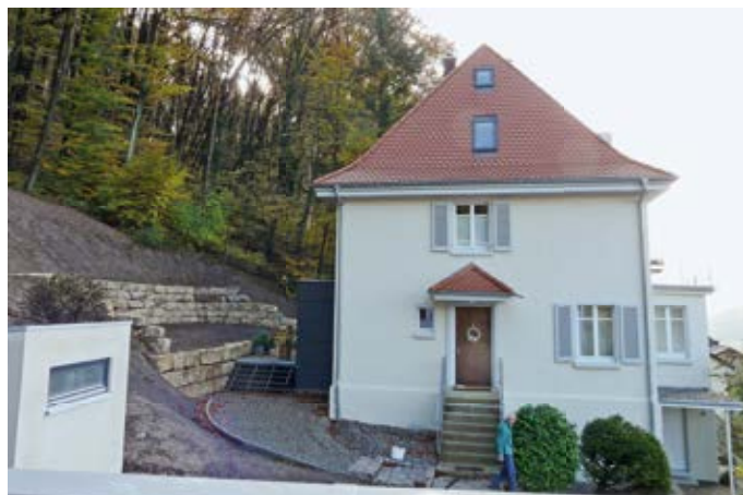
Abb. 2: Nordansicht des Altbaus mit UG massiv und OG in Holzbauweise neu gedämmt mit GUTEX Holzfaserdämmung (Bild: GUTEX)
