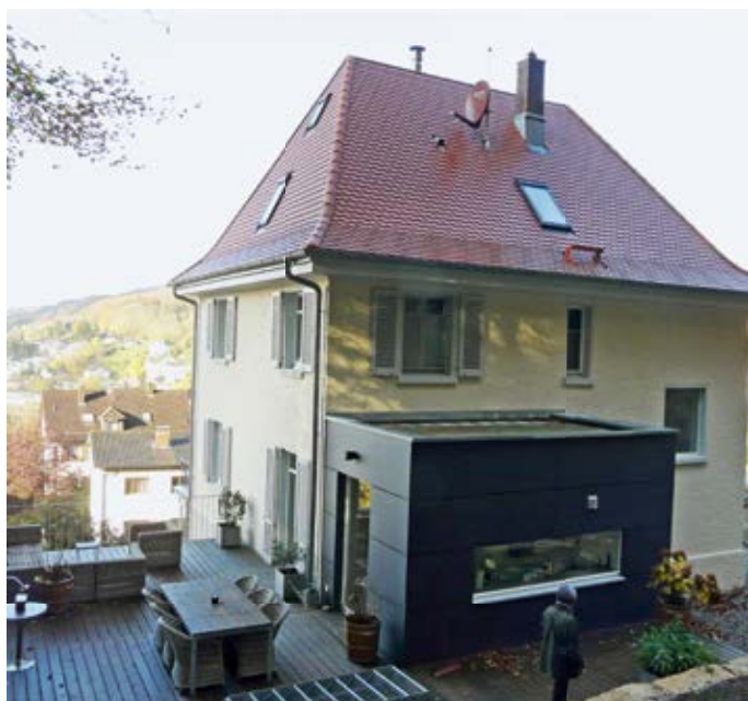
Abb. 3: Süd-Ostansicht mit Holzbau-Anbau (Bild: GUTEX)
