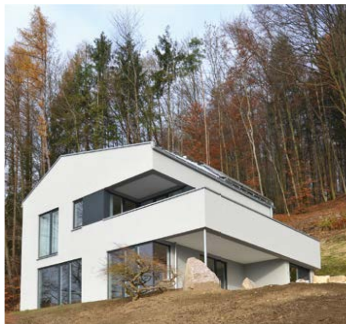
Abb. 4: Holzhausneubau mit GUTEX Holz- faserdämmung in Dach- und Wand- aufbau (Bild: Duffner Architekten BDA)
