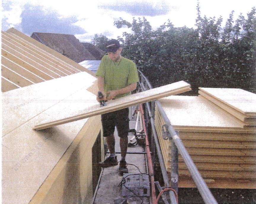
◀ Die Aufdachdämmung erfolgt mit einer regensicheren Unterdeckplatte
