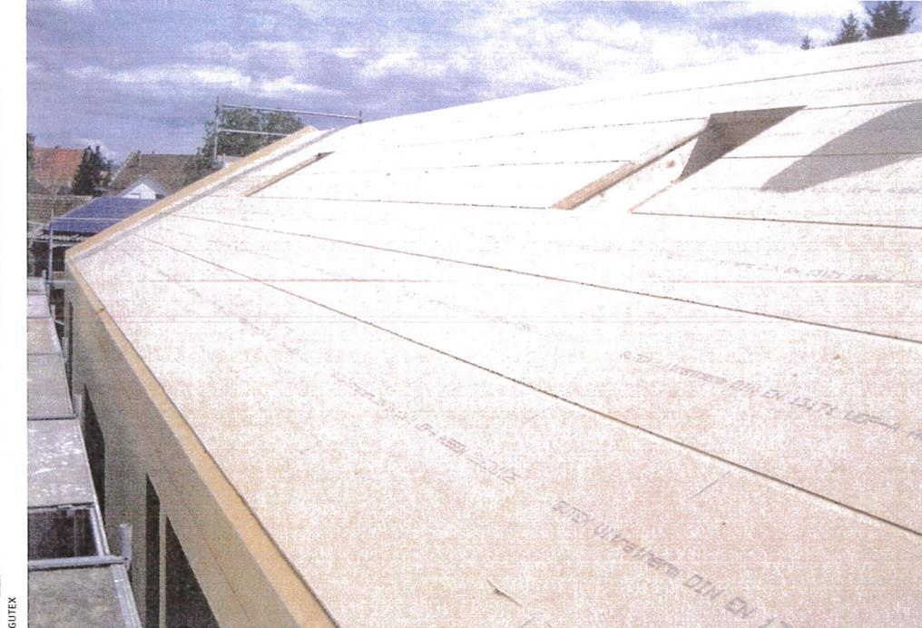
▲ Im Dachaufbau kamen 180 mm Zellulose-Einblasdämmung und 60 mm Holzfaserdämmplatten (60 mm) als Unterdeckplatten zum Einsatz
